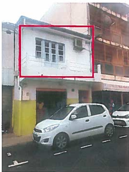
Façade du logement
